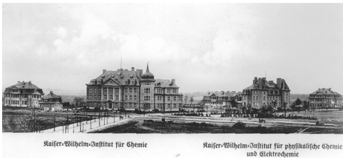
Das Gebäude mittig heute "Otto-Hahn-Bau" der Freien Universität Berlin
